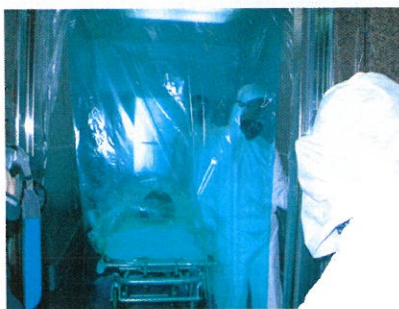
エレベーター内の養生
